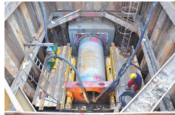
Budowa kanalizacji deszczowej w ul. Kobylńskiego metodą mikrotunelingu
