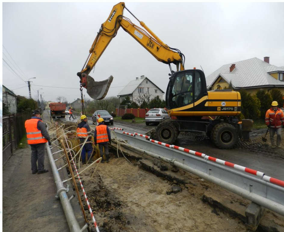
Prace przy budowie kanalizacji w Górach i Ciechomicach
