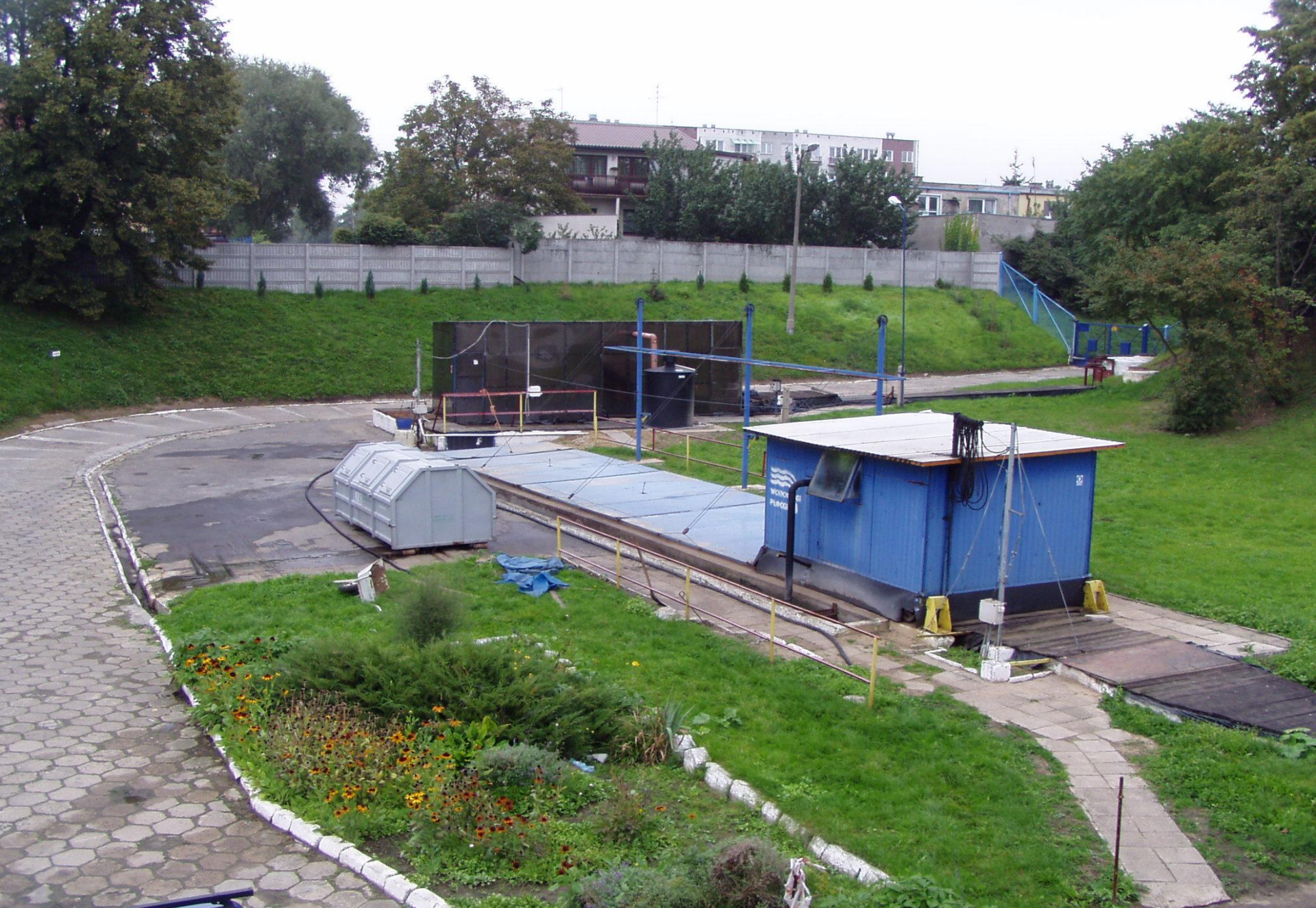
Przepompownia ścieków przy ul. Jasnej – przed modernizacją
