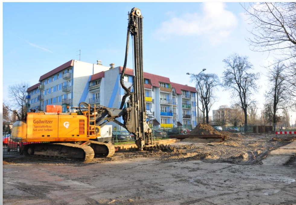
Budowa kanalizacji deszczowej w ul. Polnej
