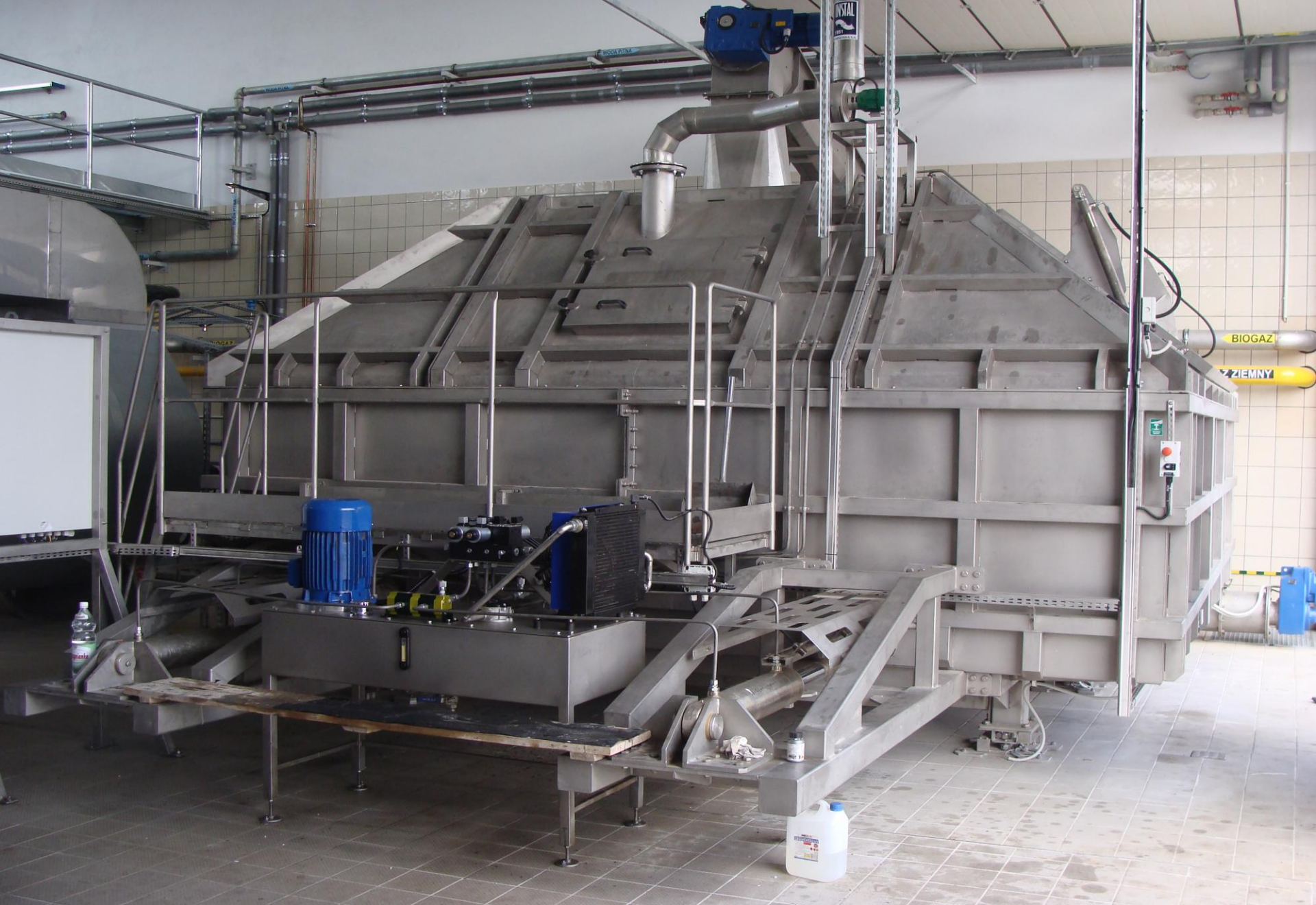
Suszarnia osadów ściekowych – nowy obiekt
