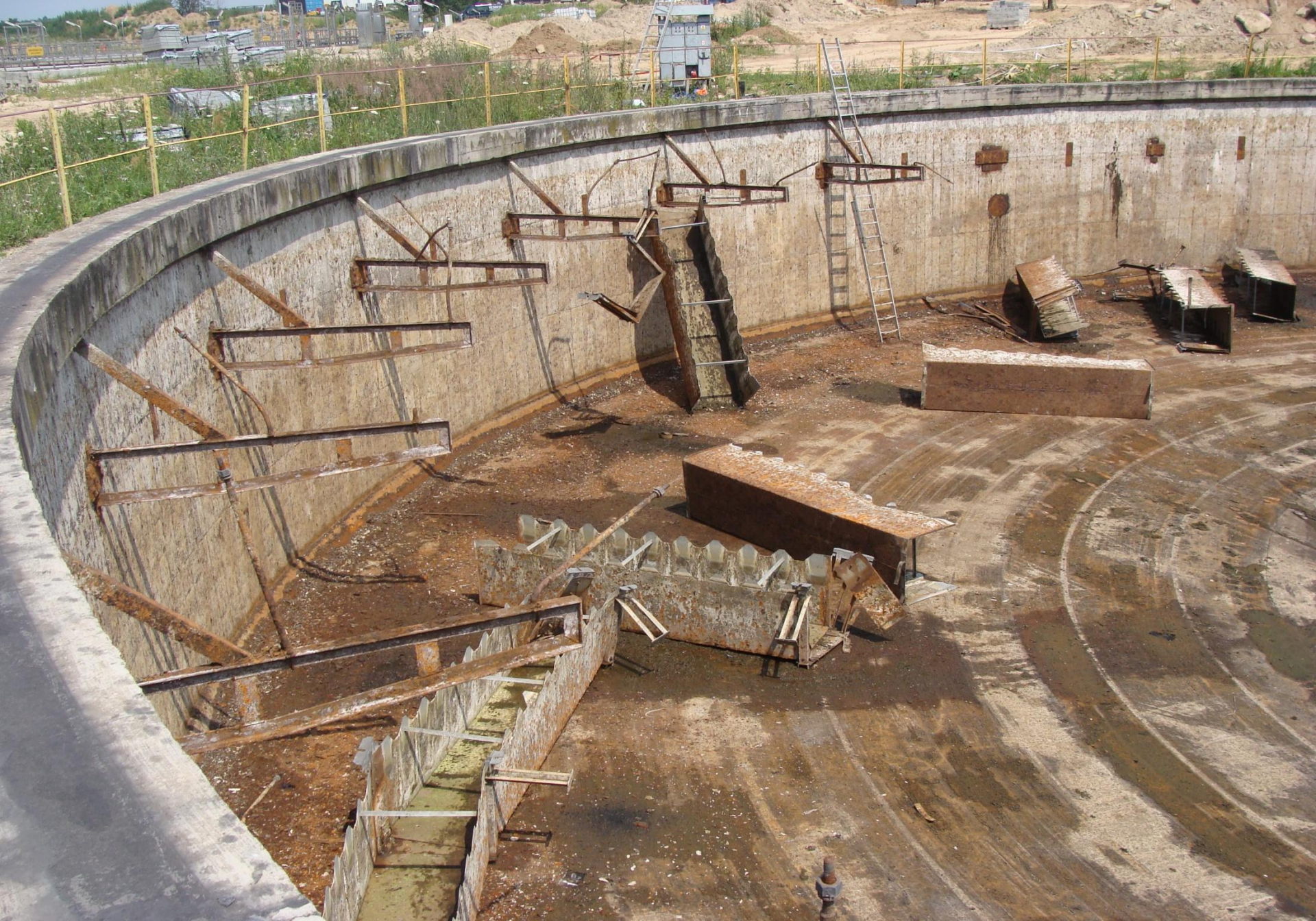
Osadniki wtórne przed modernizacją
