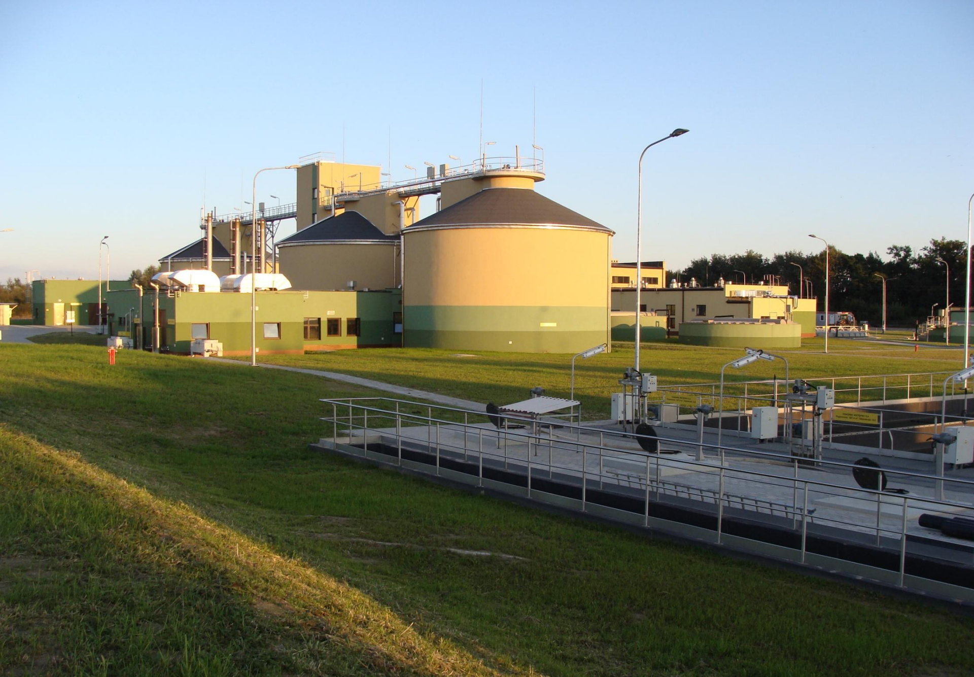
Wydzielone komory fermentacyjne po modernizacji
