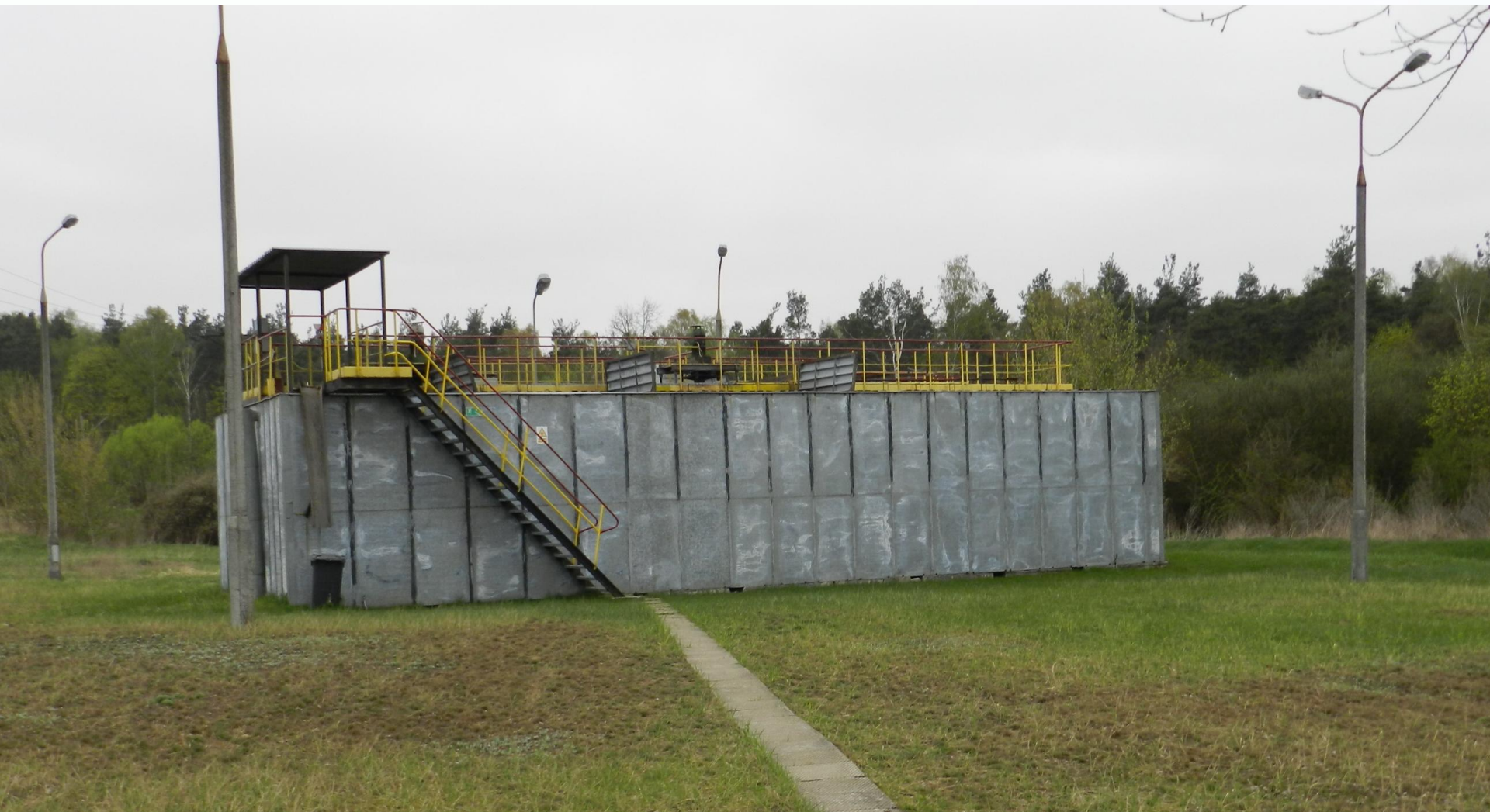
Oczyszczalnia ścieków w Górach przed likwidacją, 2013 r.
