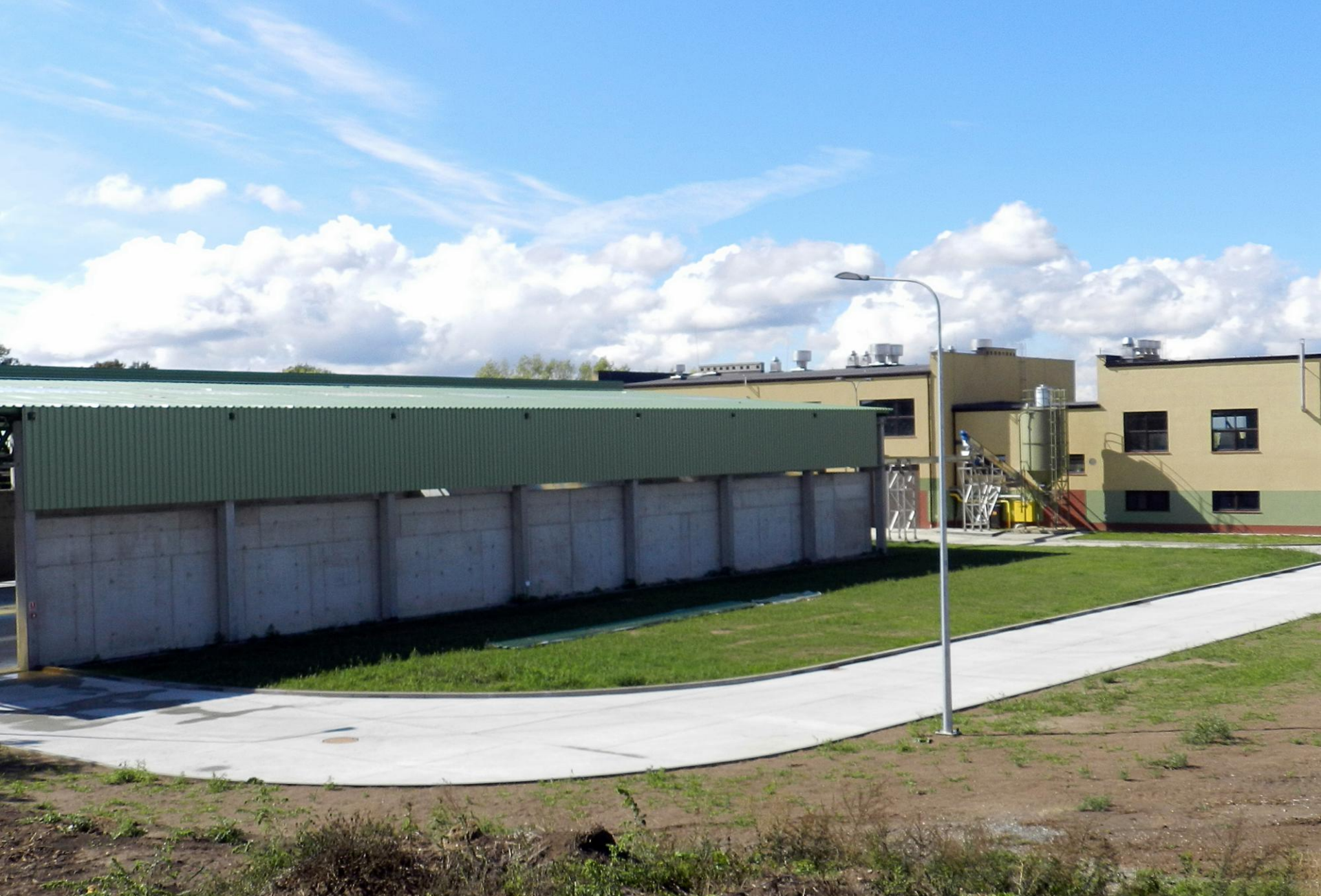
Hala magazynowa - nowy obiekt
