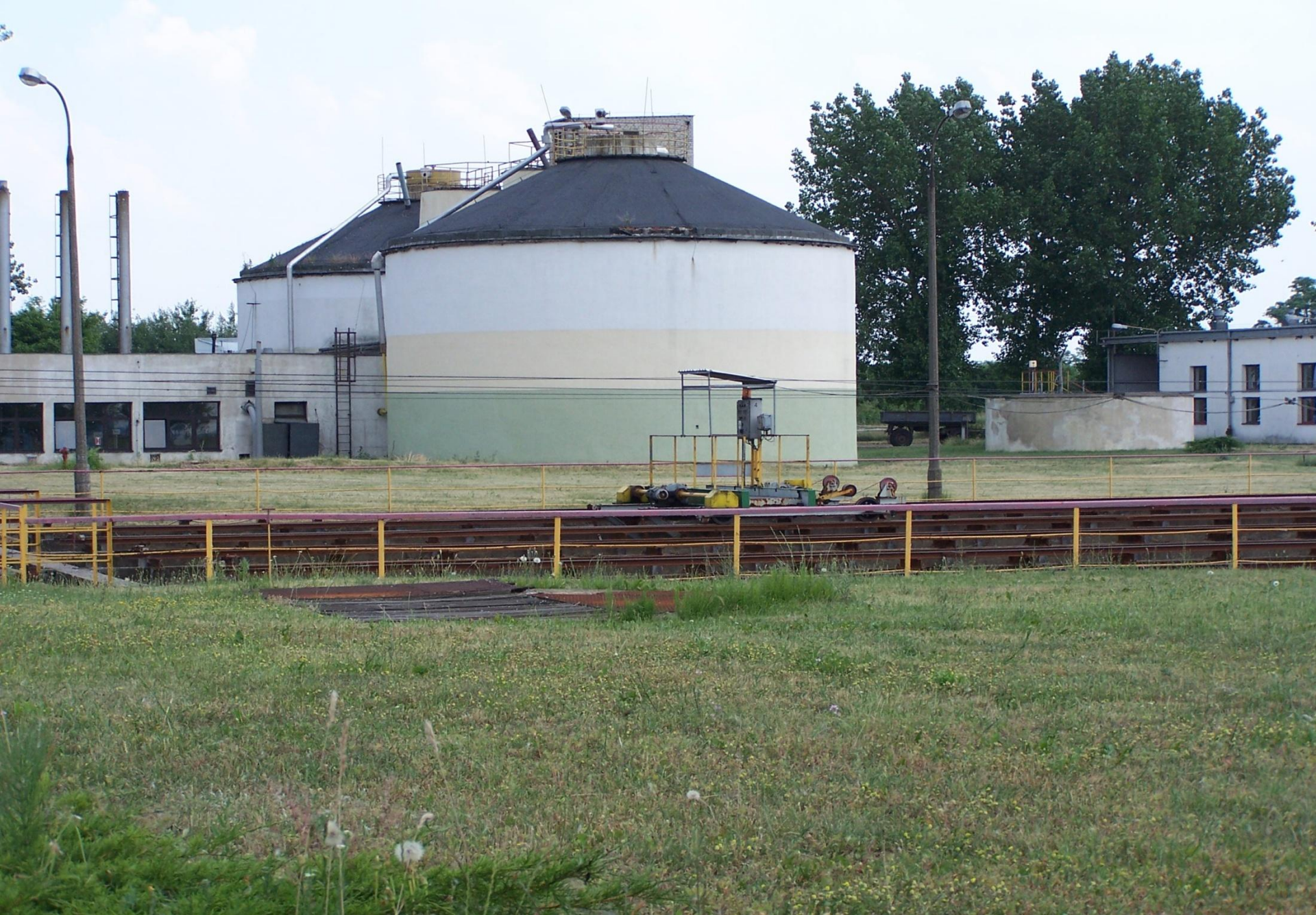
Wydzielone komory fermentacyjne przed modernizacją
