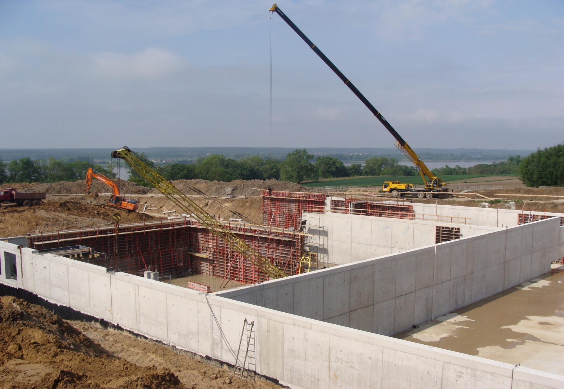
Komory nitryfikacji i denitryfikacji w trakcie budowy
