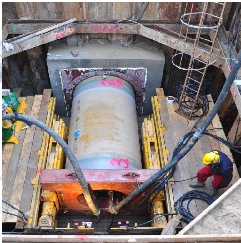
Komora startowa w ul. Kobylińskiego
