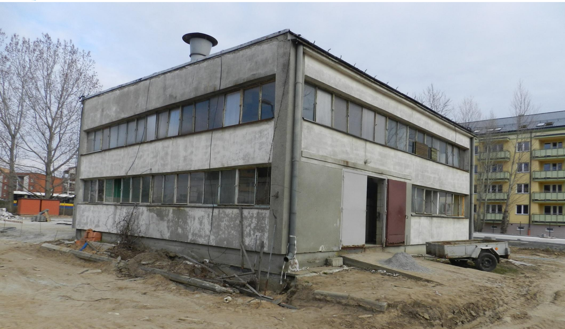
Przepompownia ścieków P5 przy ul. Mazura – przed modernizacją
