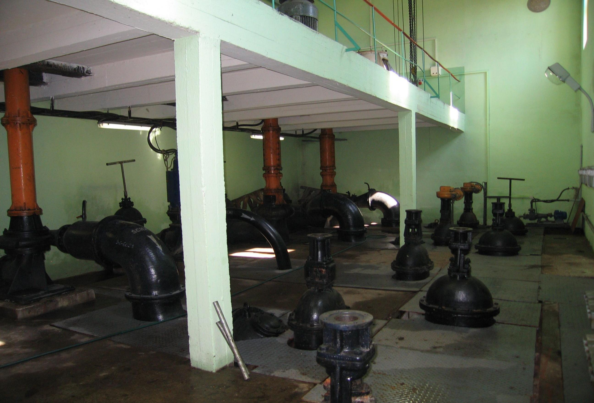
Hala pomp przy ul. Jasnej – przed modernizacją
