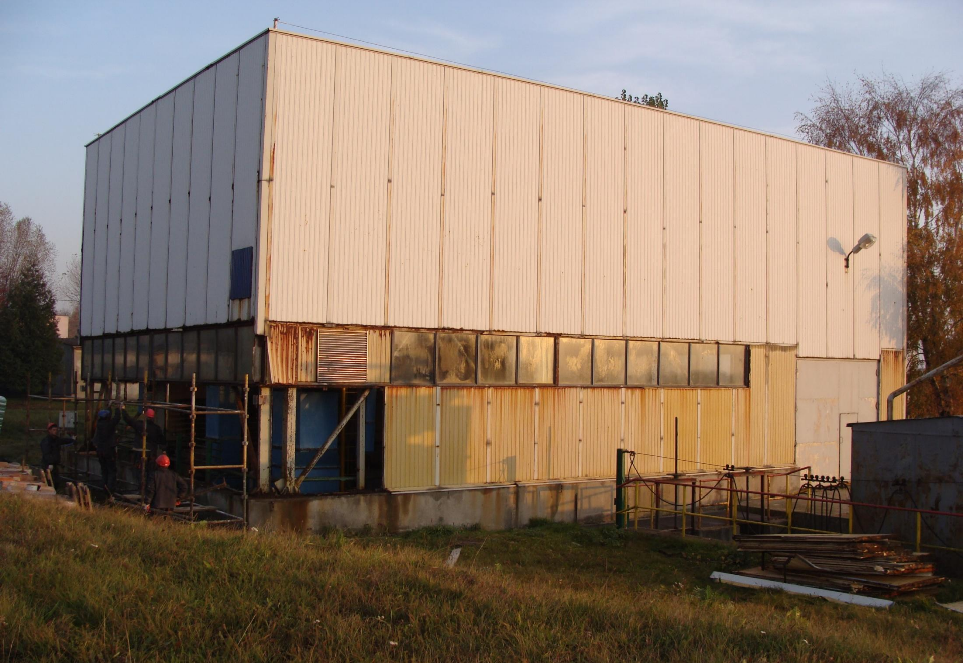
Budynek krat przed modernizacją
