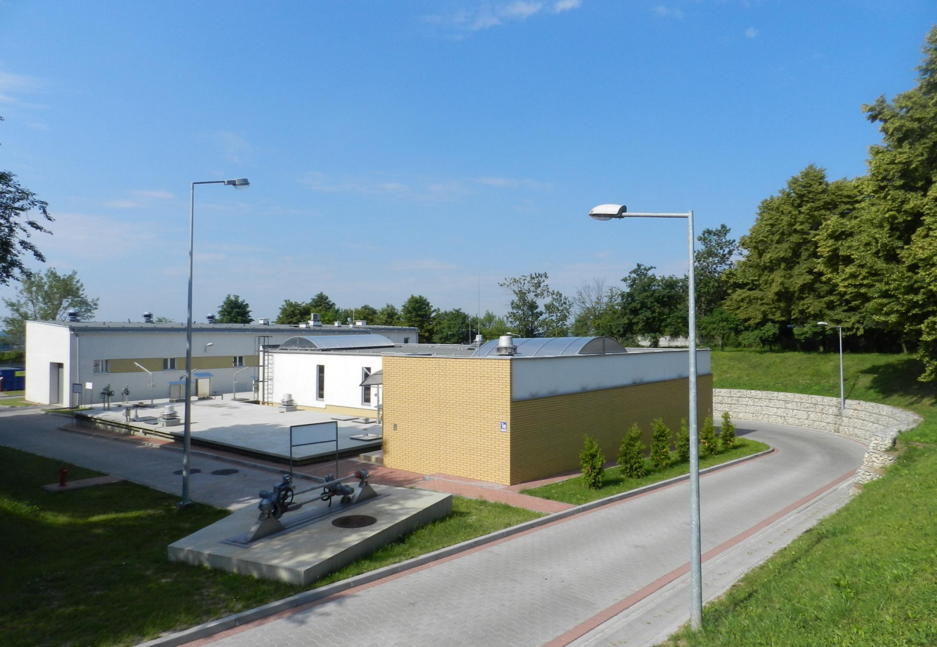
Przepompownia ścieków przy ul. Jasnej – po modernizacji
