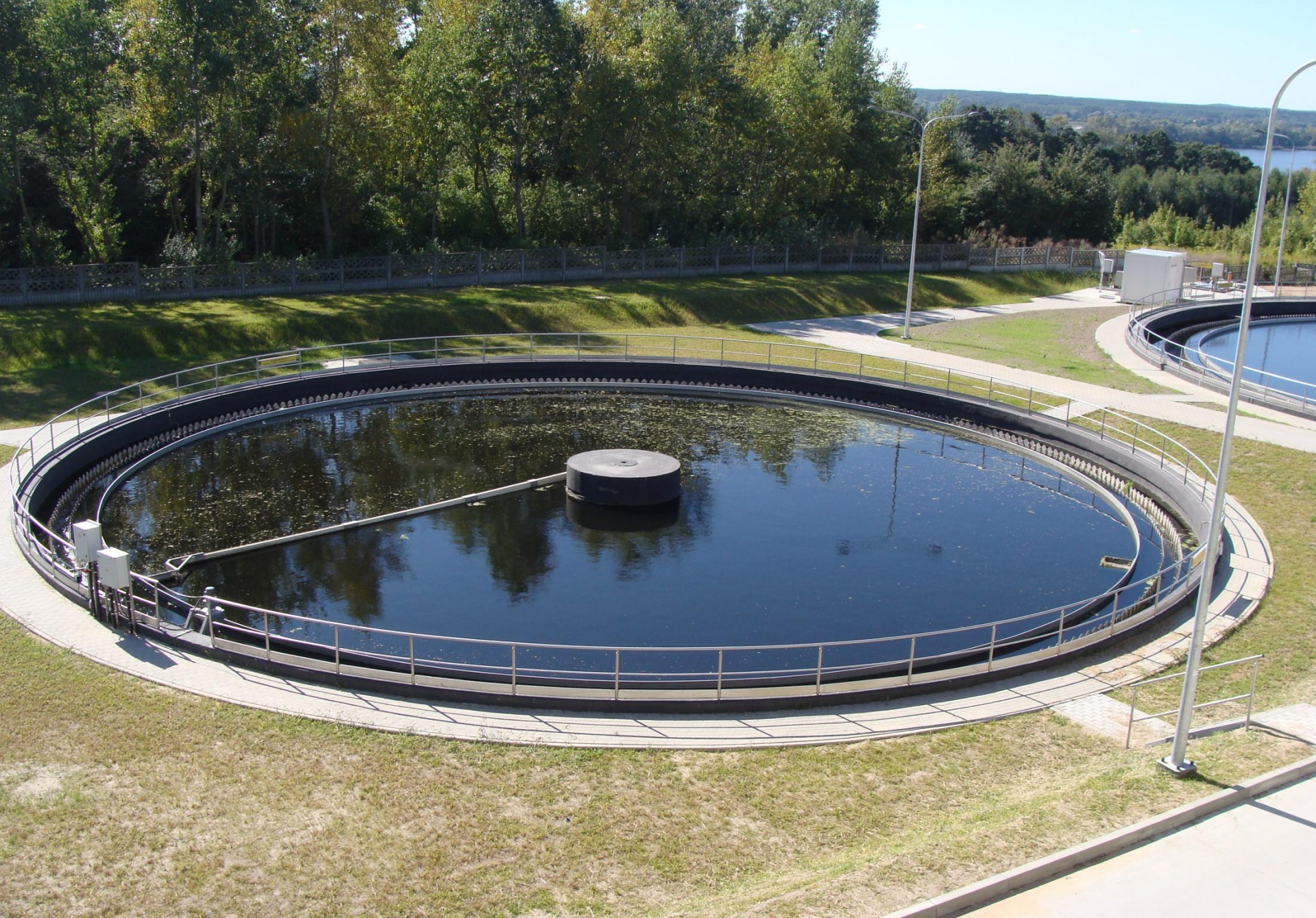
Osadniki wtórne po modernizacji
