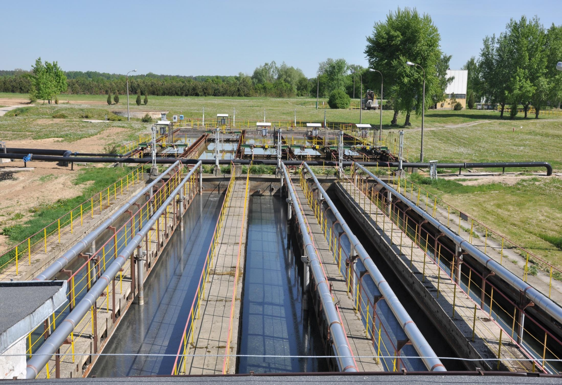
Osadniki wstępne przed modernizacją
