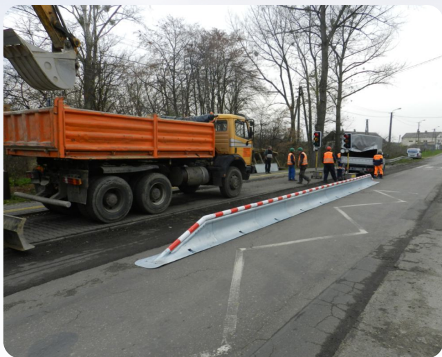
Budowa kanalizacji w ul. Góry
