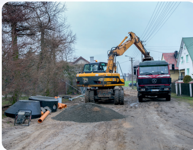
Budowa kanalizacji w ul. Nowoosiedlowej
