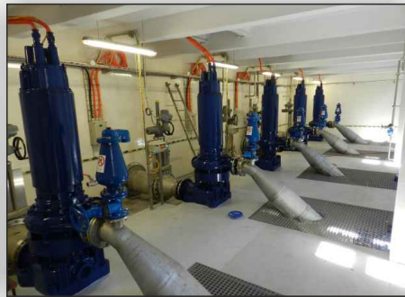
Hala pomp po modernizacji
