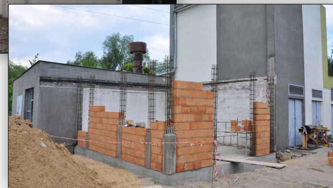
Budynek przepompowni wody w trakcie modernizacji
