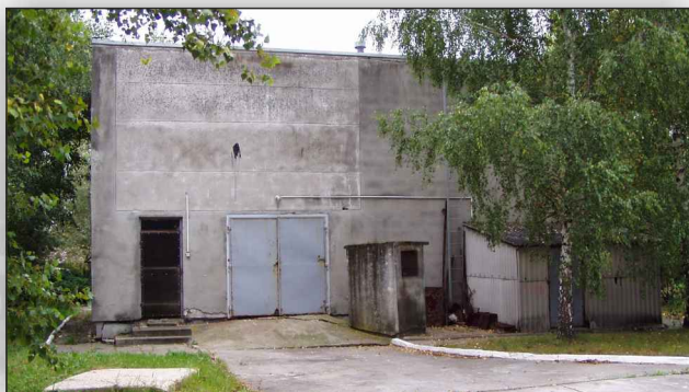
Przepompownia ścieków przy ul. Mazura przed modernizacją
