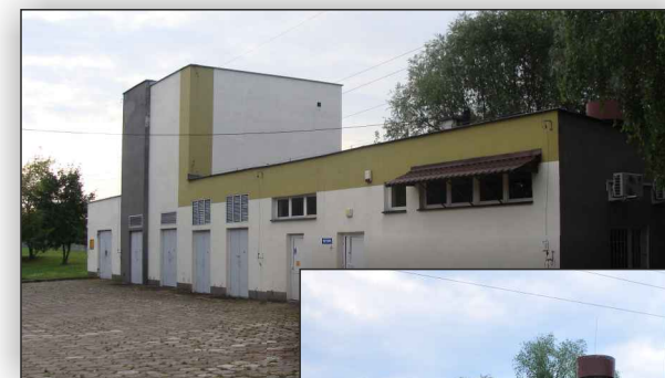
Budynek przepompowni wody przed modernizacją
