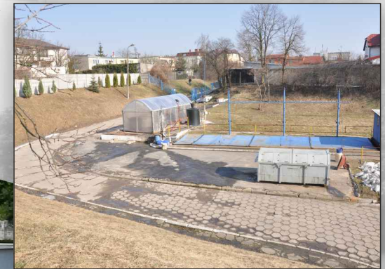
Przepompownia ścieków przy ul. Jasnej przed modernizacją
