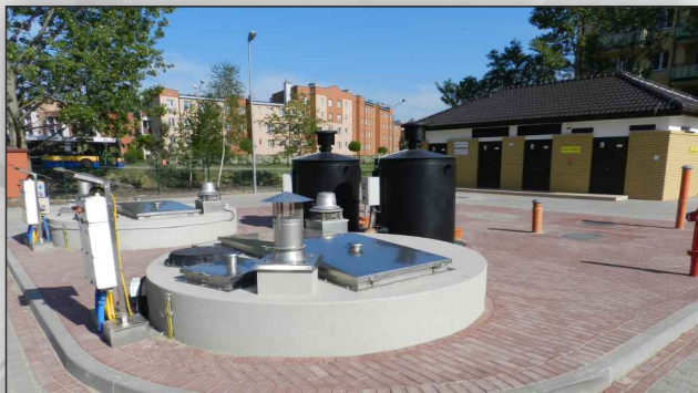
Przepompownia ścieków przy ul. Mazura po modernizacji
