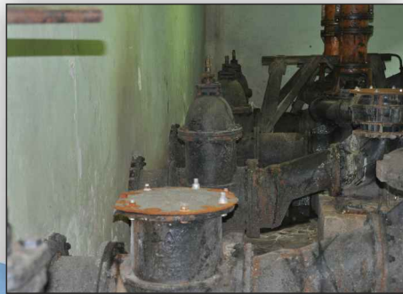
Hala pomp przed modernizacją
