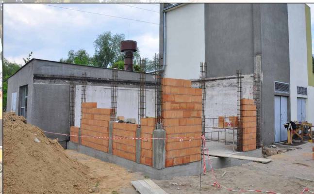
Budynek przepompowni wody w trakcie modernizacji
