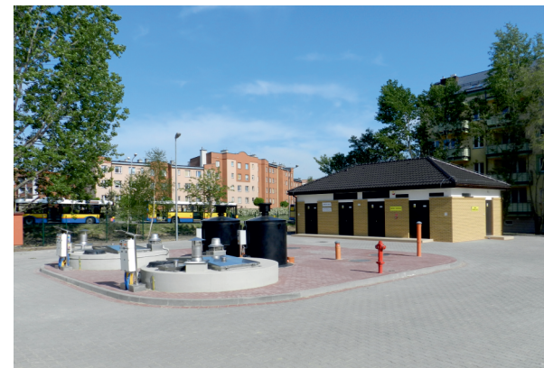
Przepompownia ścieków przy ulicy Mazura
