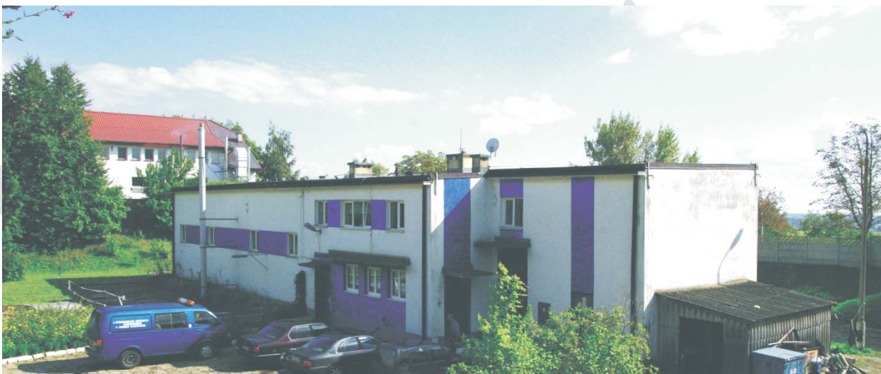
Przepompownia ścieków sanitarnych przy ul. Jasnej
