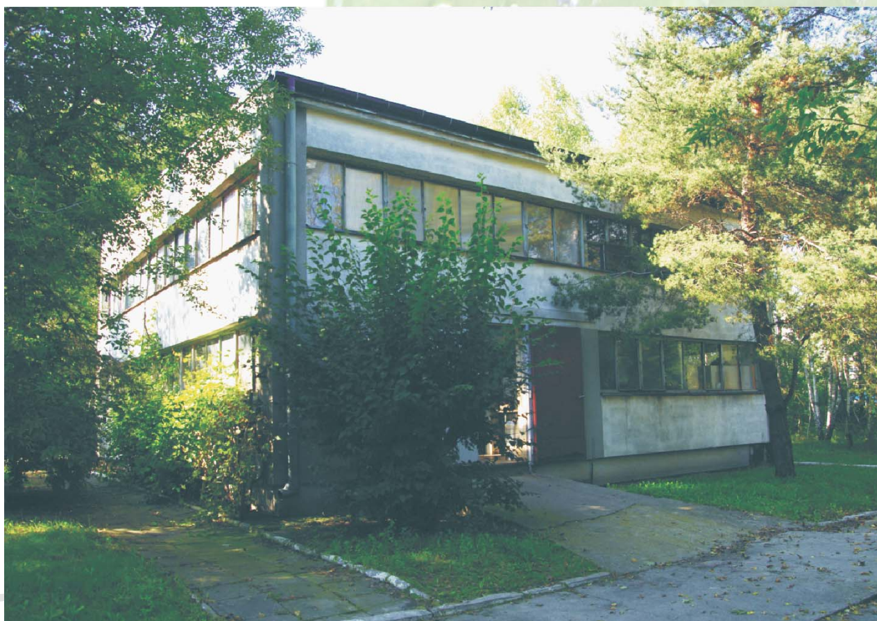
Przepompownia ścieków sanitarnych przy ul. Mazura
