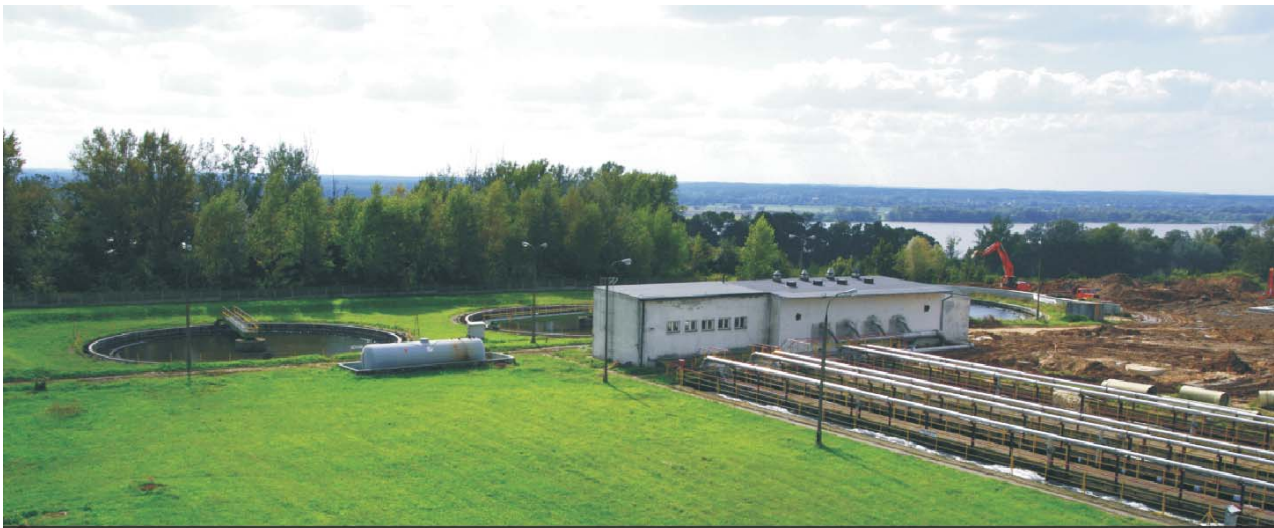
Oczyszczalnia ścieków w Maszewie
