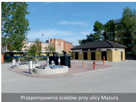
Przepompownia ścieków przy ulicy Mazura
