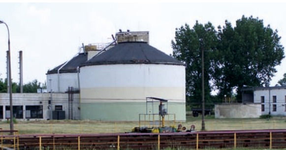
Wydzielone Komory Fermentacyjne przed przebudową
