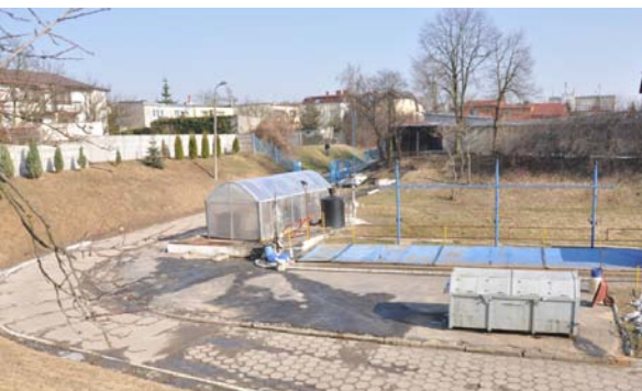
Przepompownia ścieków przy ul. Jasnej przed przebudową.
