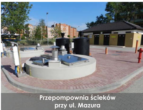
Przepompownia ścieków przy ul. Mazura przed modernizacją
