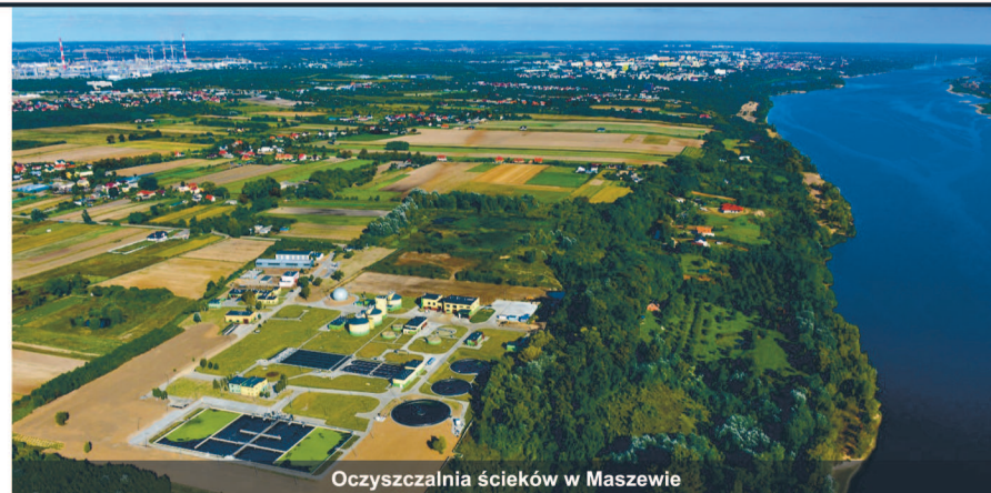
Oczyszczalnia ścieków w Maszewie
