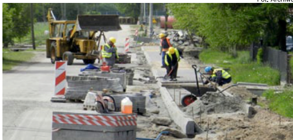
Budowa kanalizacji sanitarnej w ul. Łąckiej
