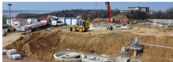
Budowa oczyszczalni wód opadowych
