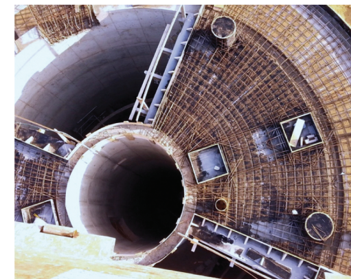
Budowa kanału spiralnego - oczyszczalnia wód opadowych
