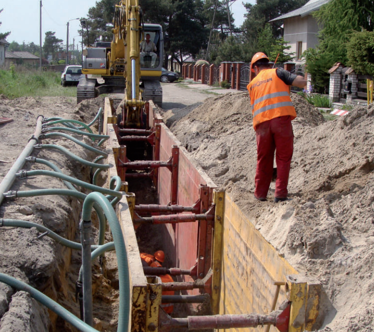
Osiedle Borowiczki - budowa kanalizacji sanitarnej, lipiec 2008
