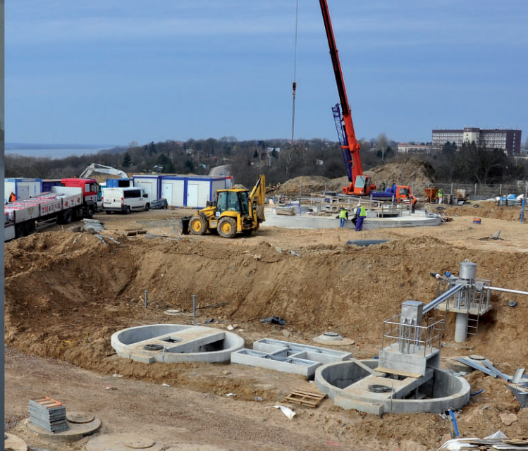
Budowa oczyszczalni wód opadowych, marzec 2015
