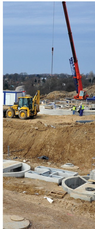
Budowa kanału spiralnego - oczyszczalnia wód opadowych
