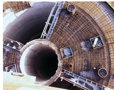
Budowa kanału spiralnego - oczyszczalnia wód opadowych
